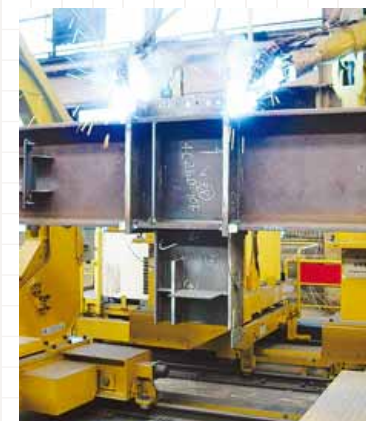
SRC 2-ARC welding
